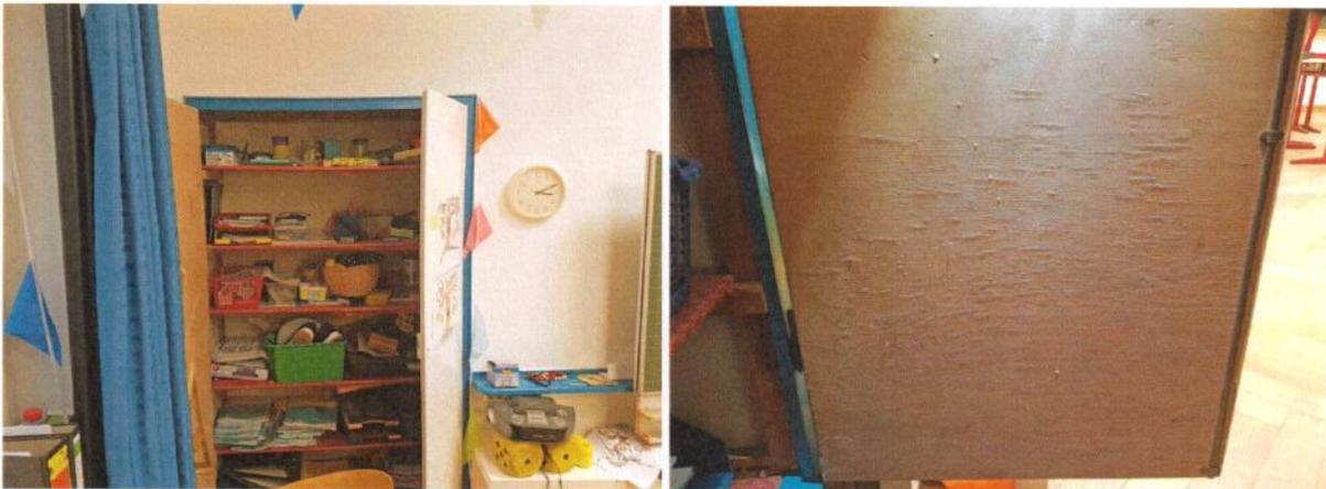
Abb. 13 + 14: Klassenraum 15. Die Innenseite der rechten Wandschrantür ist massiv verschimmelt. Der Befall ist erst im Streiflicht der Taschenlampe augenscheinlich wahrnehmbar (Bild rechts).
