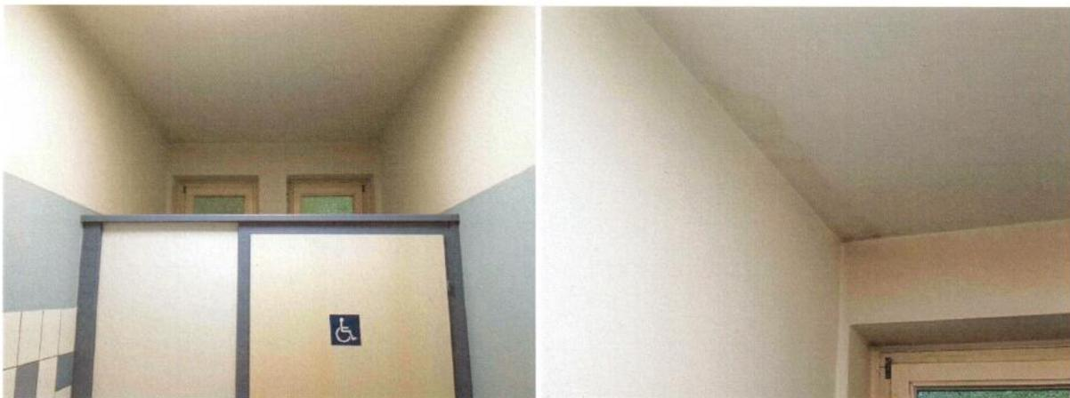
Abb. 9 + 10: Jungen-WC (Raum 8). Oberhalb der Behindertentoilette ist an der Decke ein Feuchtigkeitsfleck erkennbar (rechts im Detail).
