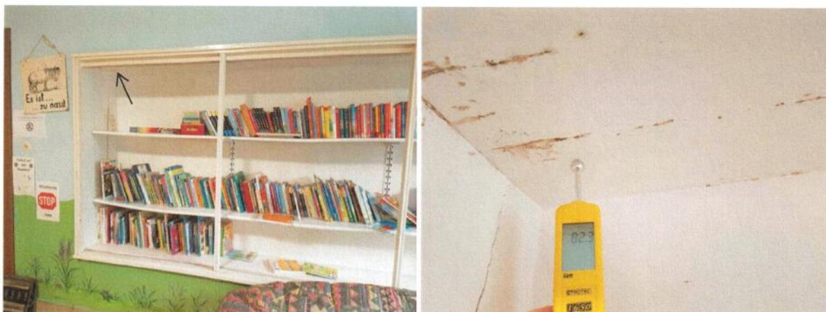
Abb. 19 + 20: Eingangshalle. Der Wandschrank in der Eingangshalle zeigt deutliche Feuchtigkeits-bedingte Verwerfungen und verströmt einen schimmeligen Geruch. Die Unterseite des obersten Abschlussbretts weist erhöhte Feuchtigkeit auf (hier 82,3 digits, Feuchteindikator T650, Fa. Trotec).
