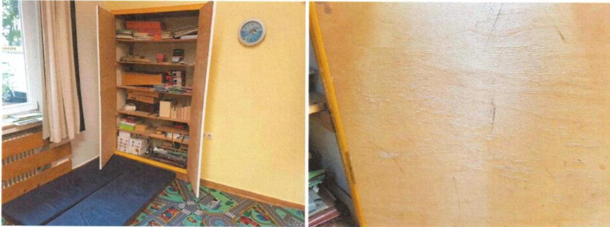
Abb. 15 + 16: Klassenraum 18. Die Innenseiten der rechten und linken Wandschränktür zeigen einen mittleren Schimmelbefall (rechts im Detail).
