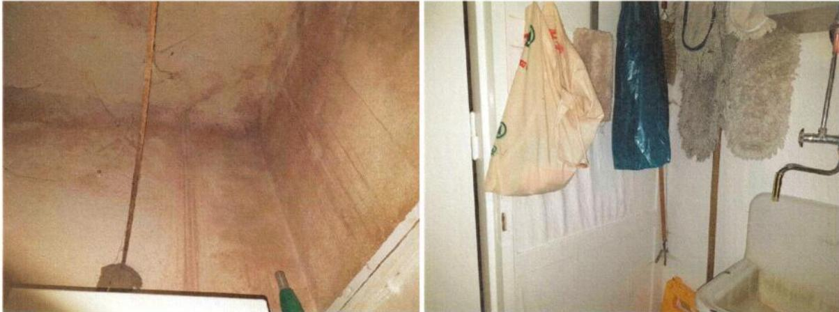
Abb. 1 + 2: Putzmittelraum im Flur vor den Klassenräumen 1 und 2. Links ist der Wandbereich oberhalb des Putzmittelraums mit den Feuchtigkeitsspuren und dem Schimmelbefall erkennbar. Rechts ist die Trennwand zum Wandschrank zu sehen, deren Oberfläche sich aufgrund von Feuchtigkeitseintrag wellt.
