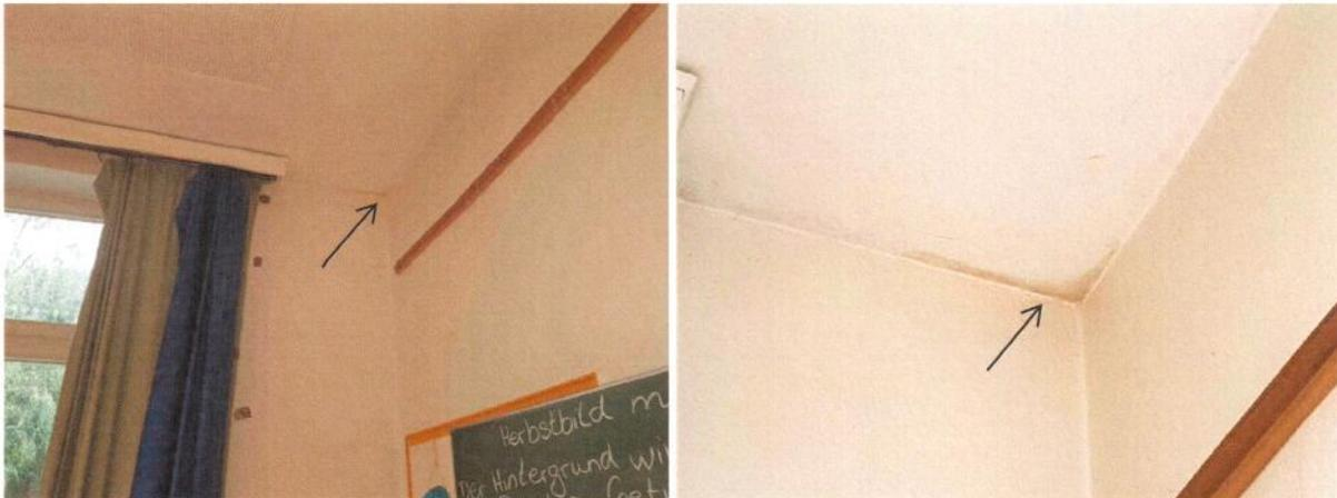
Abb. 3 + 4: Klassenraum 5. In der rechten oberen Ecke liegt ein kleinflächiger Schimmelbefall vor (rechts im Detail).
