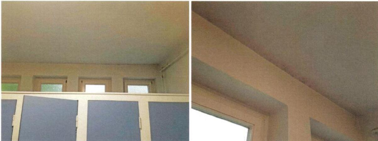
Abb. 7 + 8: Jungen-WC (Raum 8). Im großen Toilettenraum ist am Übergang zwischen Außenwand und Decke Schimmelbefall erkennbar (rechts im Detail).
