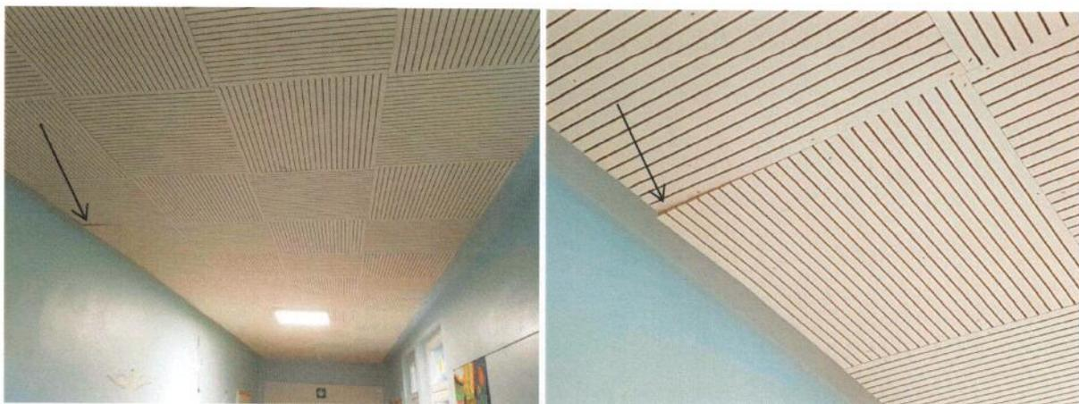
Abb. 17 + 18: Flur vor den Klassenräumen 17 und 18. Die Decke ist mit Akustikplatten verkleidet, die sich stellenweise lösen (rechts im Detail).
