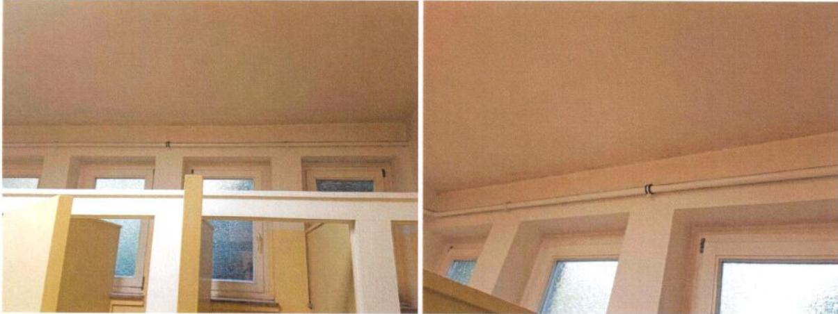
Abb. 11 + 12: Mädchen-WC (Raum 9). Im großen Toilettenraum ist am Übergang zwischen Außenwand und Decke Schimmelbefall erkennbar (rechts im Detail).
